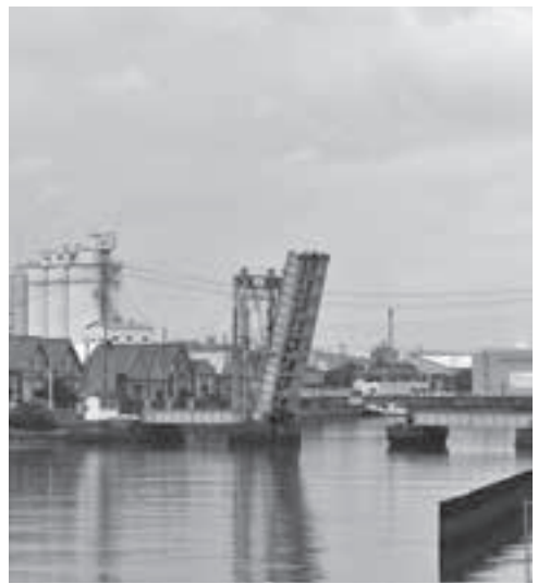
隣には昭和6年に竣工した末広橋梁
