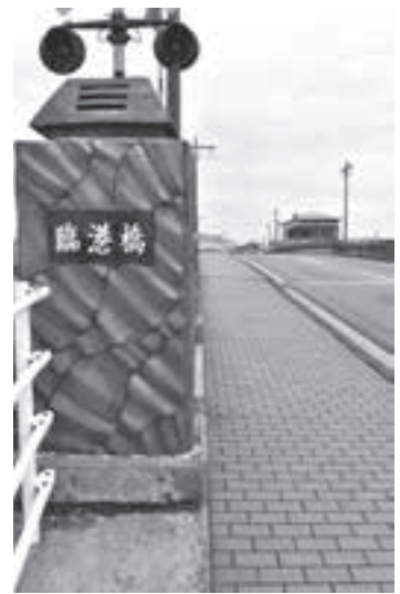
現在の橋は萬古焼の親柱がポイント
